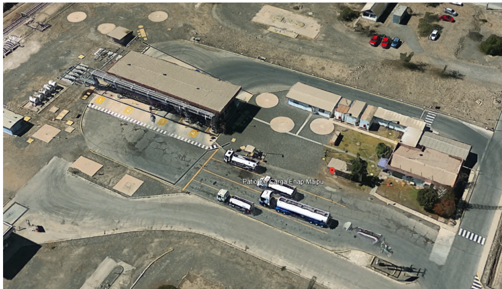
Figura 4.5: Panorámica de patio de carga de combustibles líquidos de la Planta de ENAP Maipú, obtenida de Google Earth (2024), [2]
